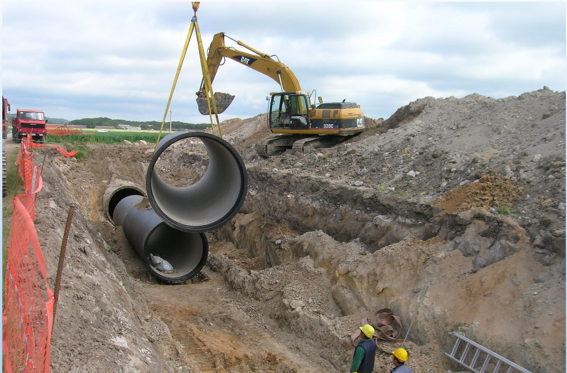
POSA DELLE TUBAZIONI IN GHISA SFEROIDALE SU LETTO DI SABBIA IN UN TRATTO INTERRATO
