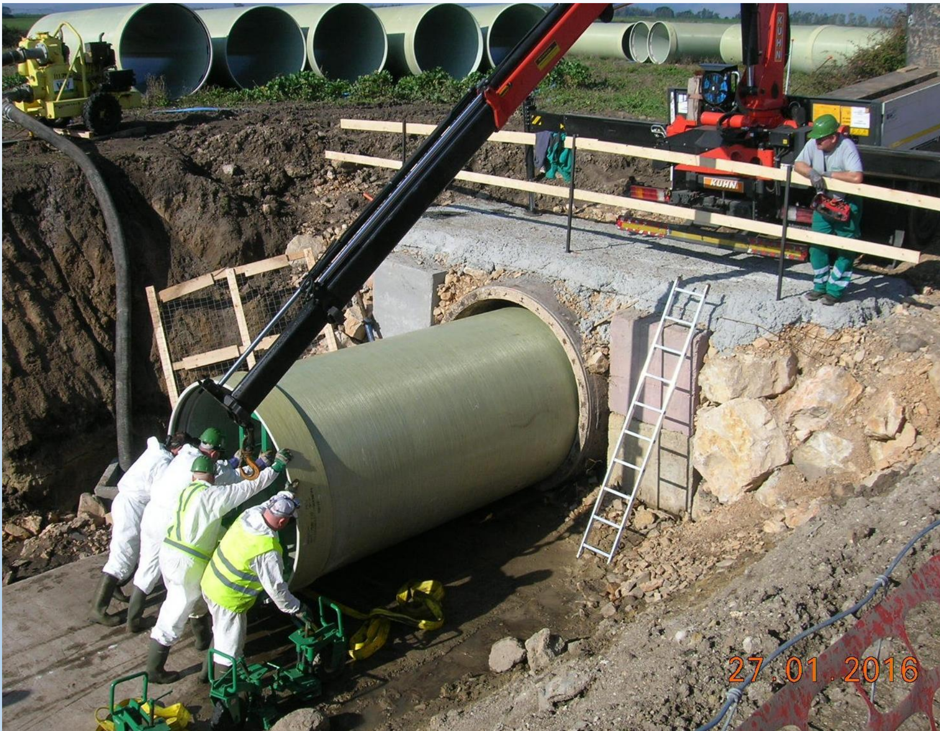
RELINING CON TUBO IN P.R.F.V. DI 1.800 MM
