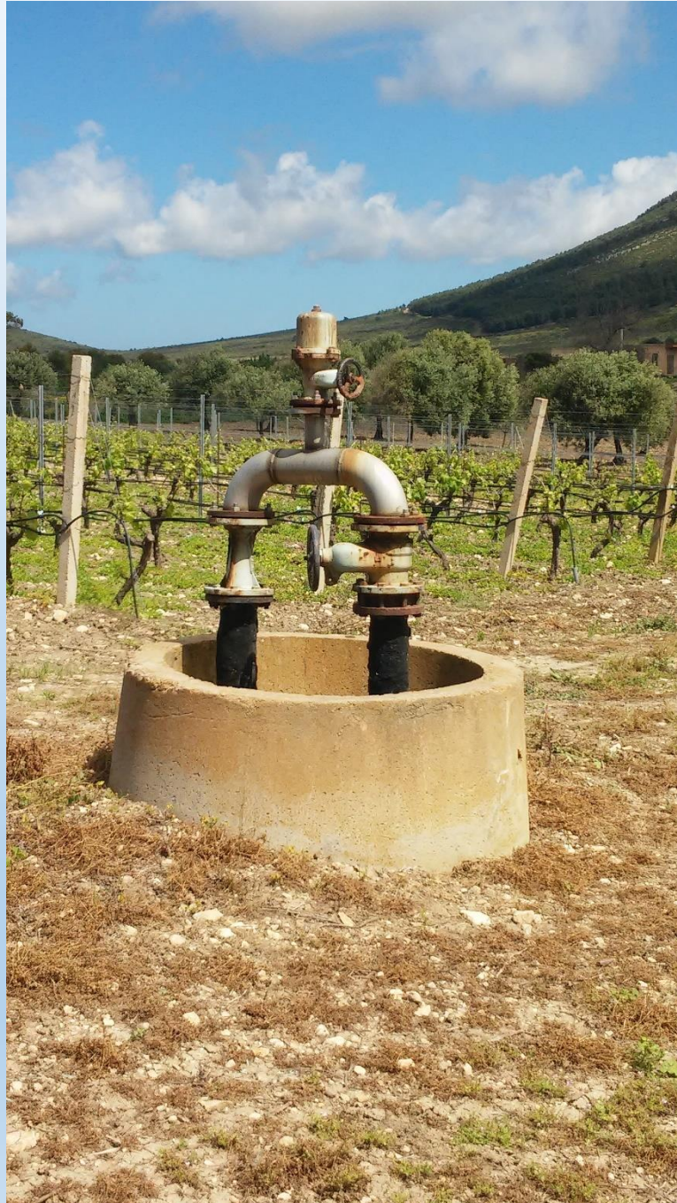
Manufatti consorzio – dettaglio saracinesca, sfiato, limitatore di portata
