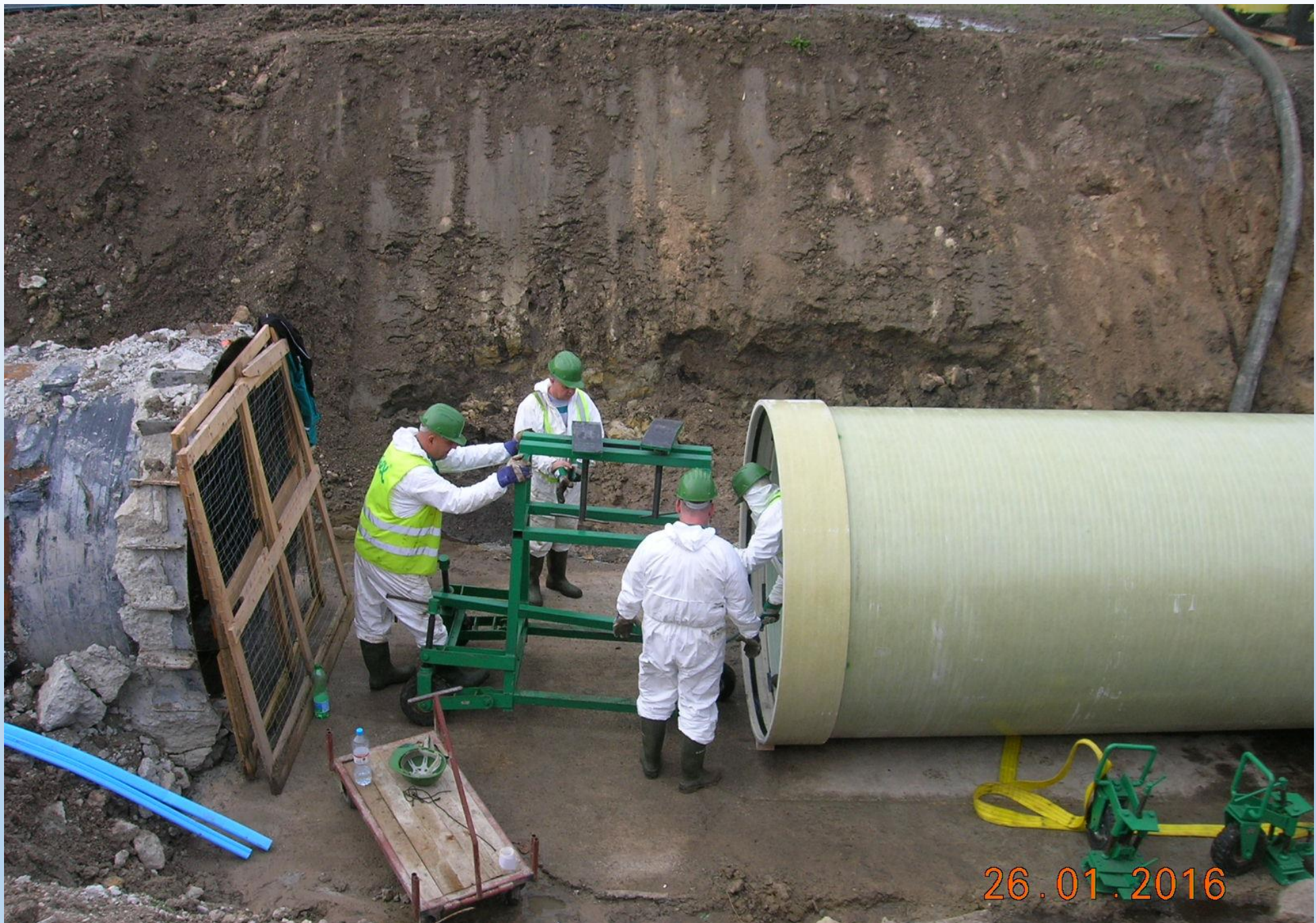
RELINING CON TUBO IN P.R.F.V. DI 1.800 MM
