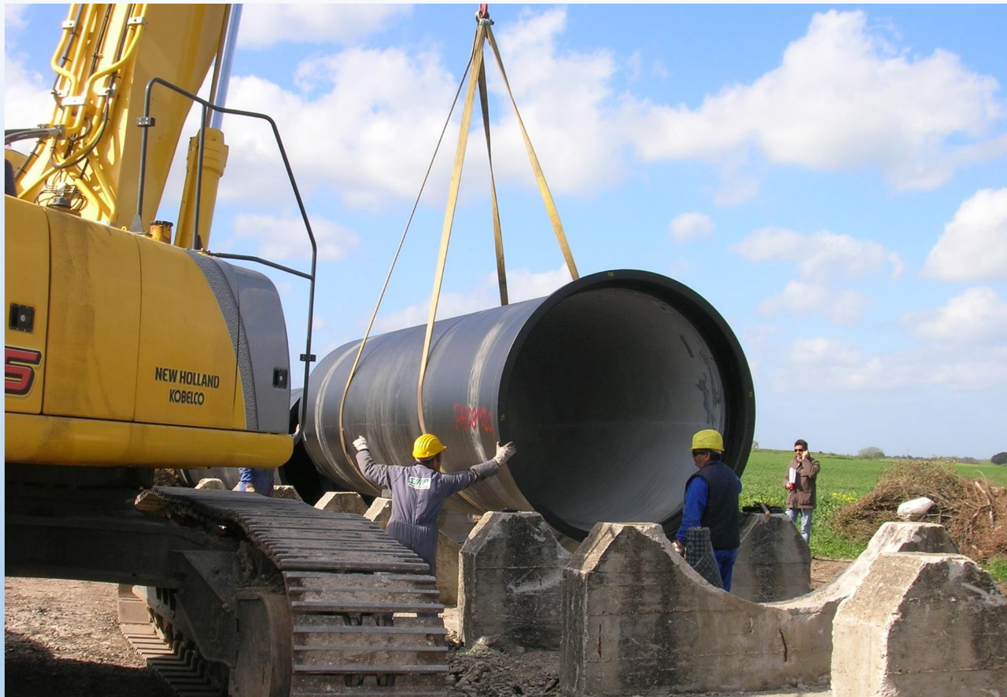
POSA DELLE TUBAZIONI IN GHISA SFEROIDALE SU SELLE DI APPOGGIO
