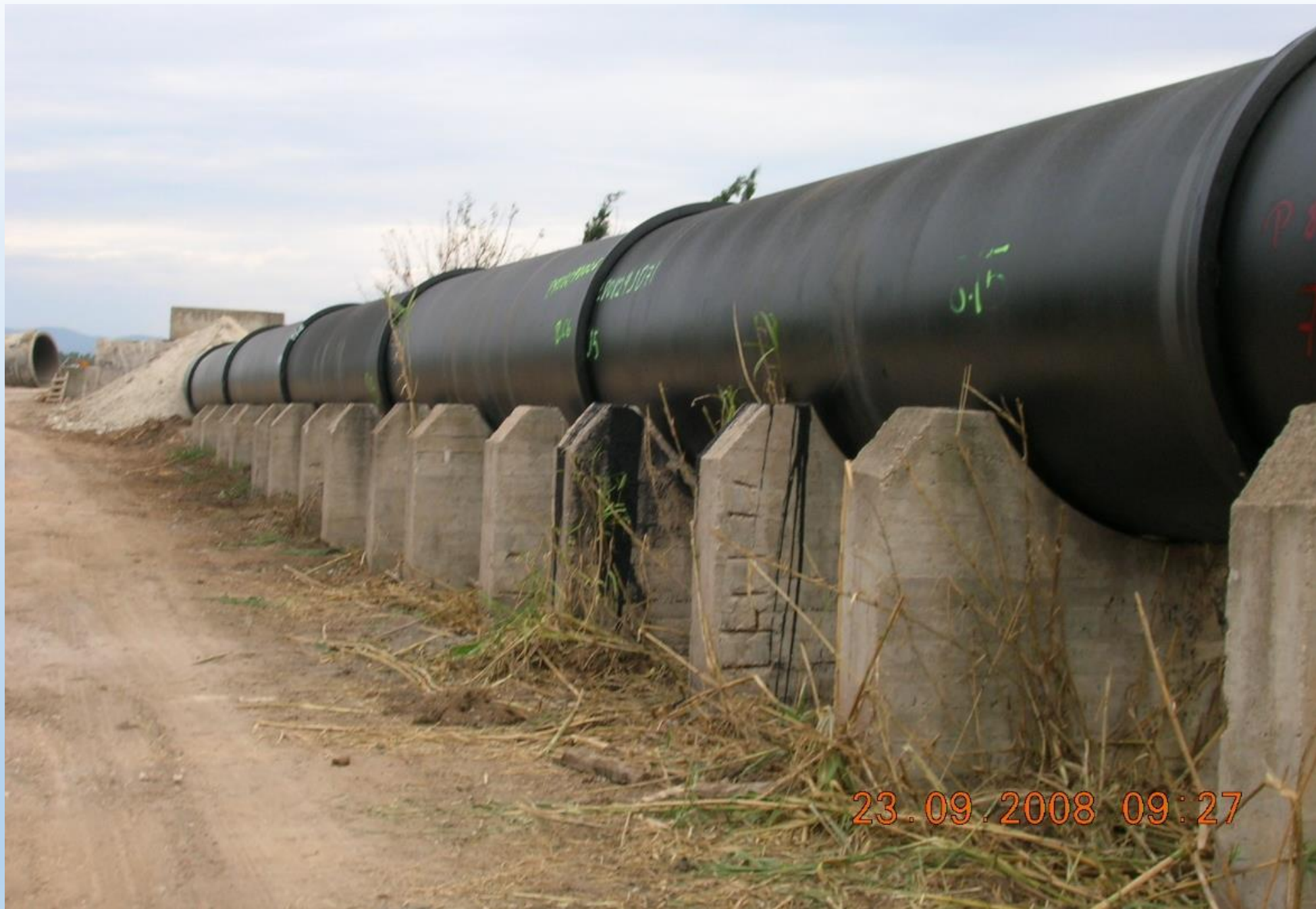
TRATTO IN GHISA SFEROIDALE GIA' POSATO SULLE SELLE DI APPOGGIO ORIGINARIE
