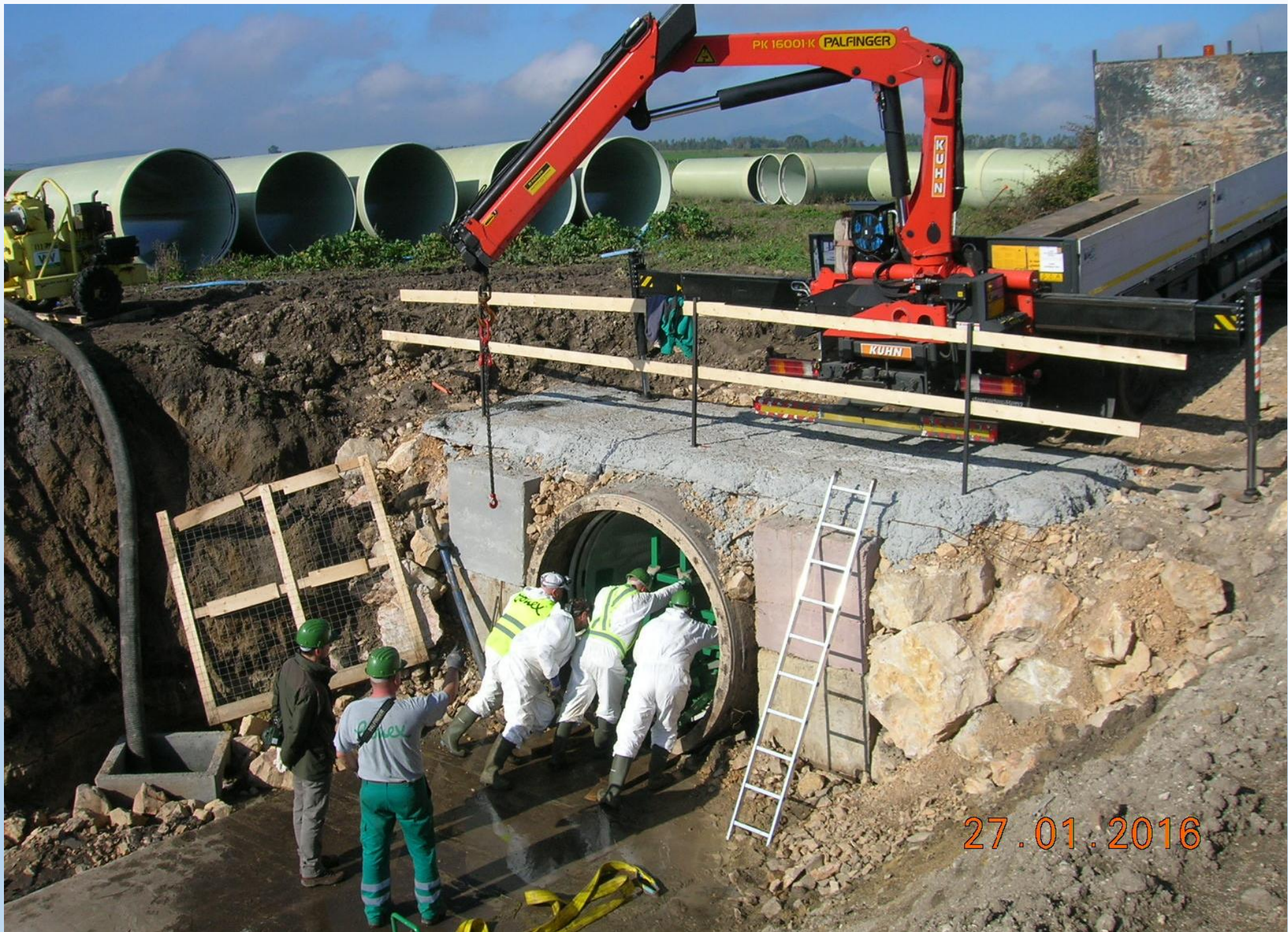
RELINING CON TUBO IN P.R.F.V. DI 1.800 MM
