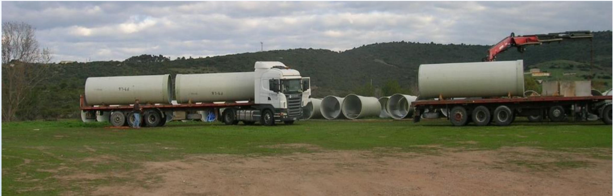
ARRIVO TUBAZIONI E PEZZI SPECIALI IN P.R.F.V. IN CANTIERE
