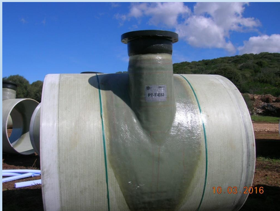
ARRIVO TUBAZIONI E PEZZI SPECIALI IN P.R.F.V. IN CANTIERE
