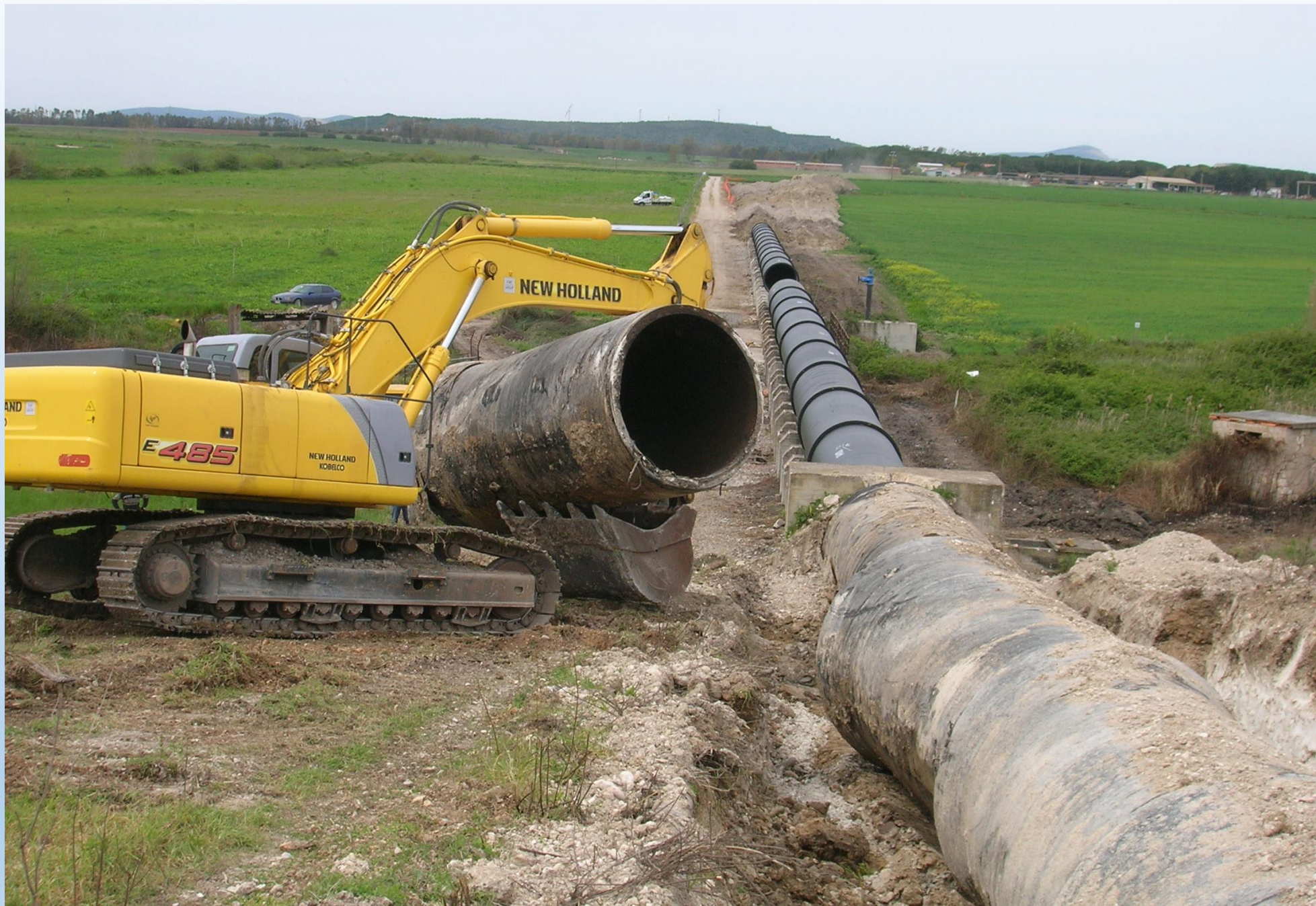
RIMOZIONE DELLE TUBAZIONI IN C.A.P.
