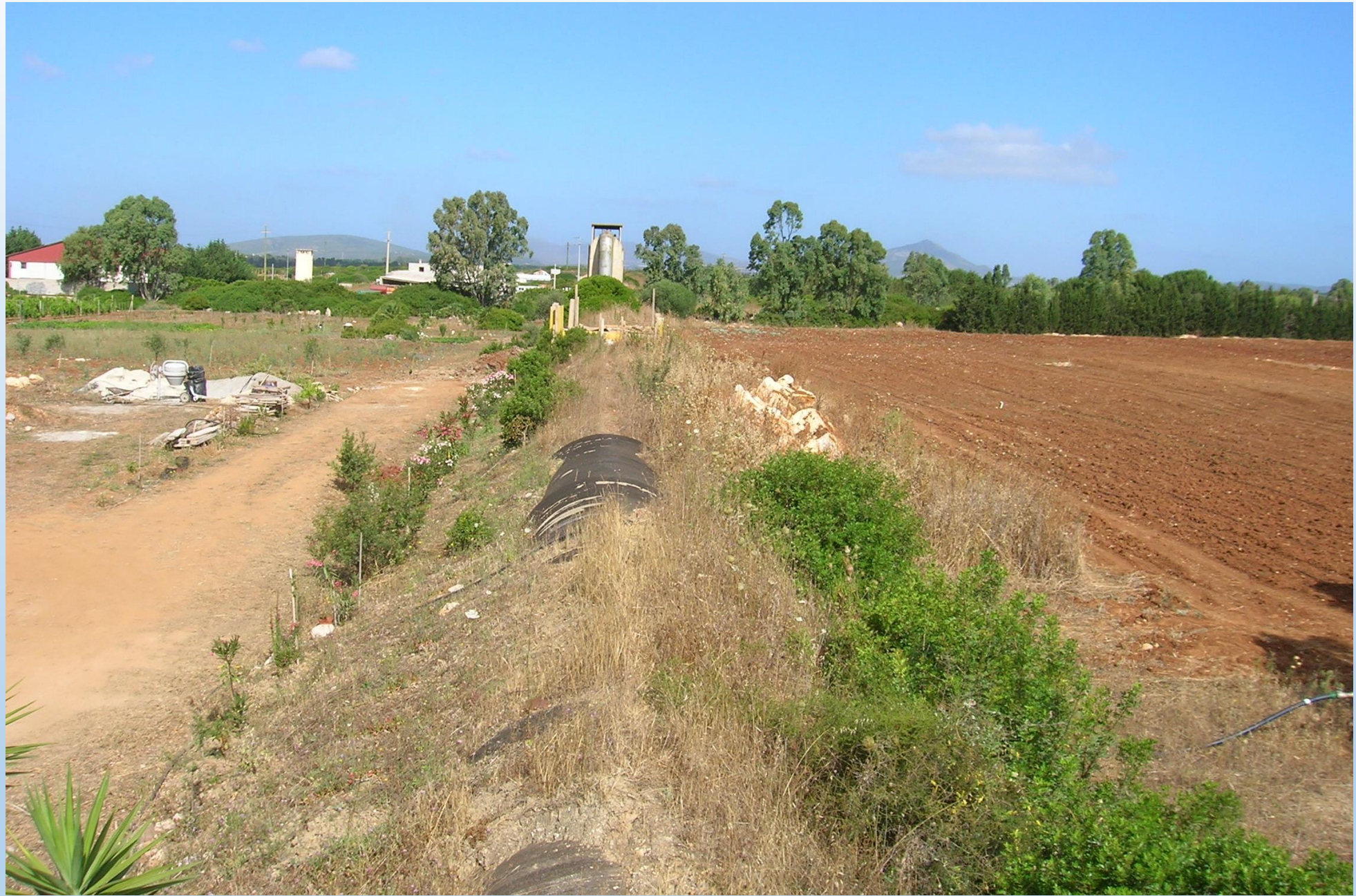
CONDOTTA ADDUTTRICE NORD IN C.A.P. DN 2.000 MM TRATTO PARZIALMENTE INTERRATO
