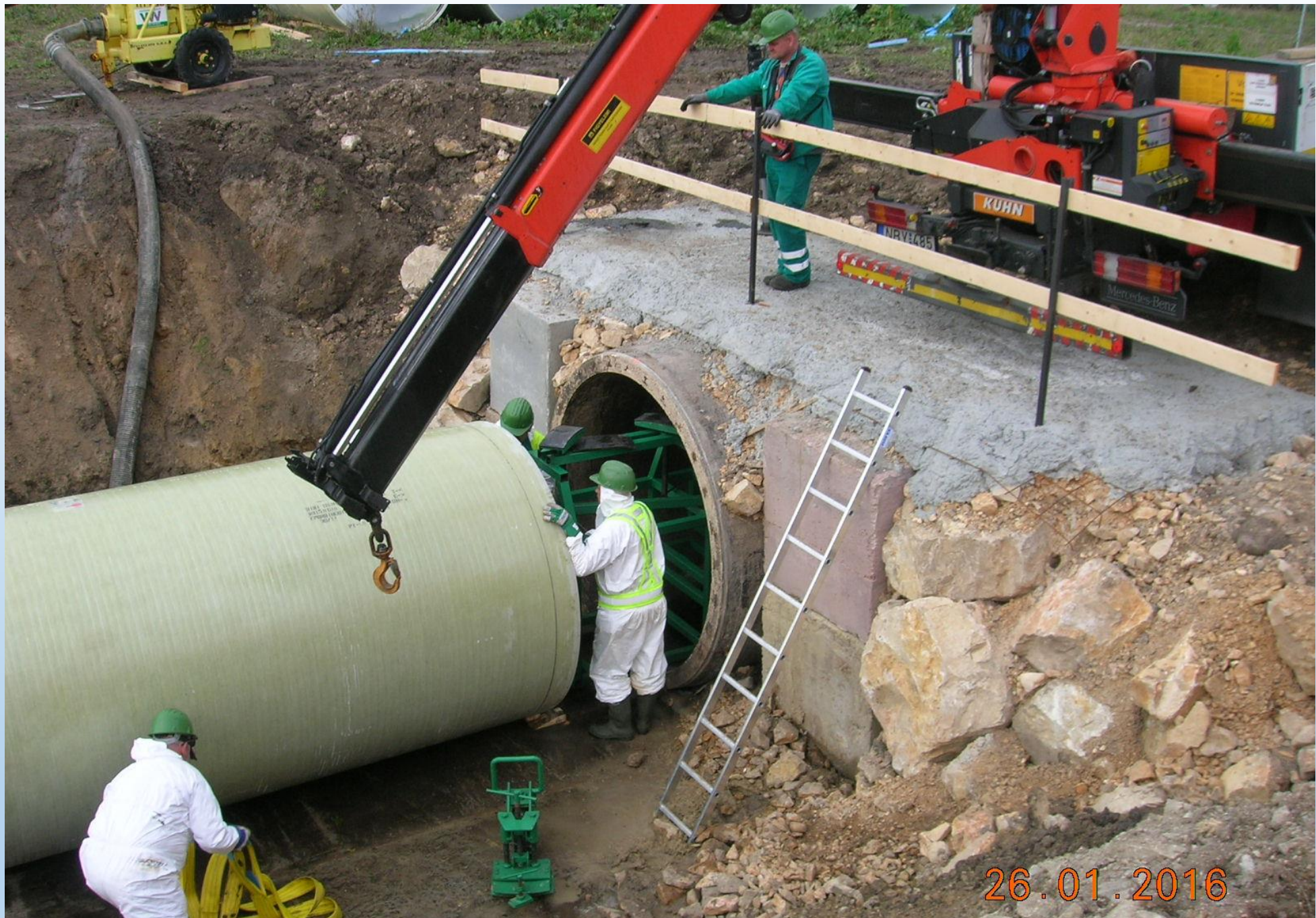
RELINING CON TUBO IN P.R.F.V. DI 1.800 MM
