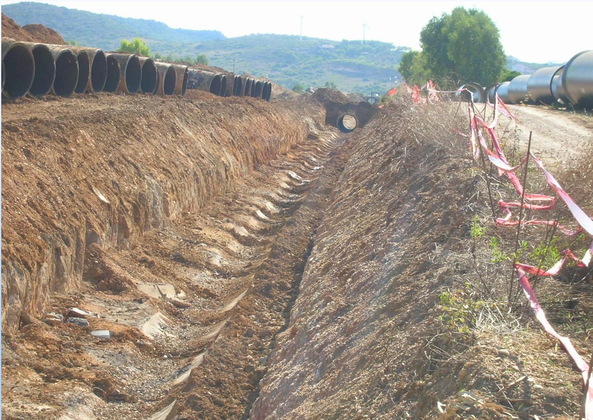
RIMOZIONE DELLE TUBAZIONI IN C.A.P.
