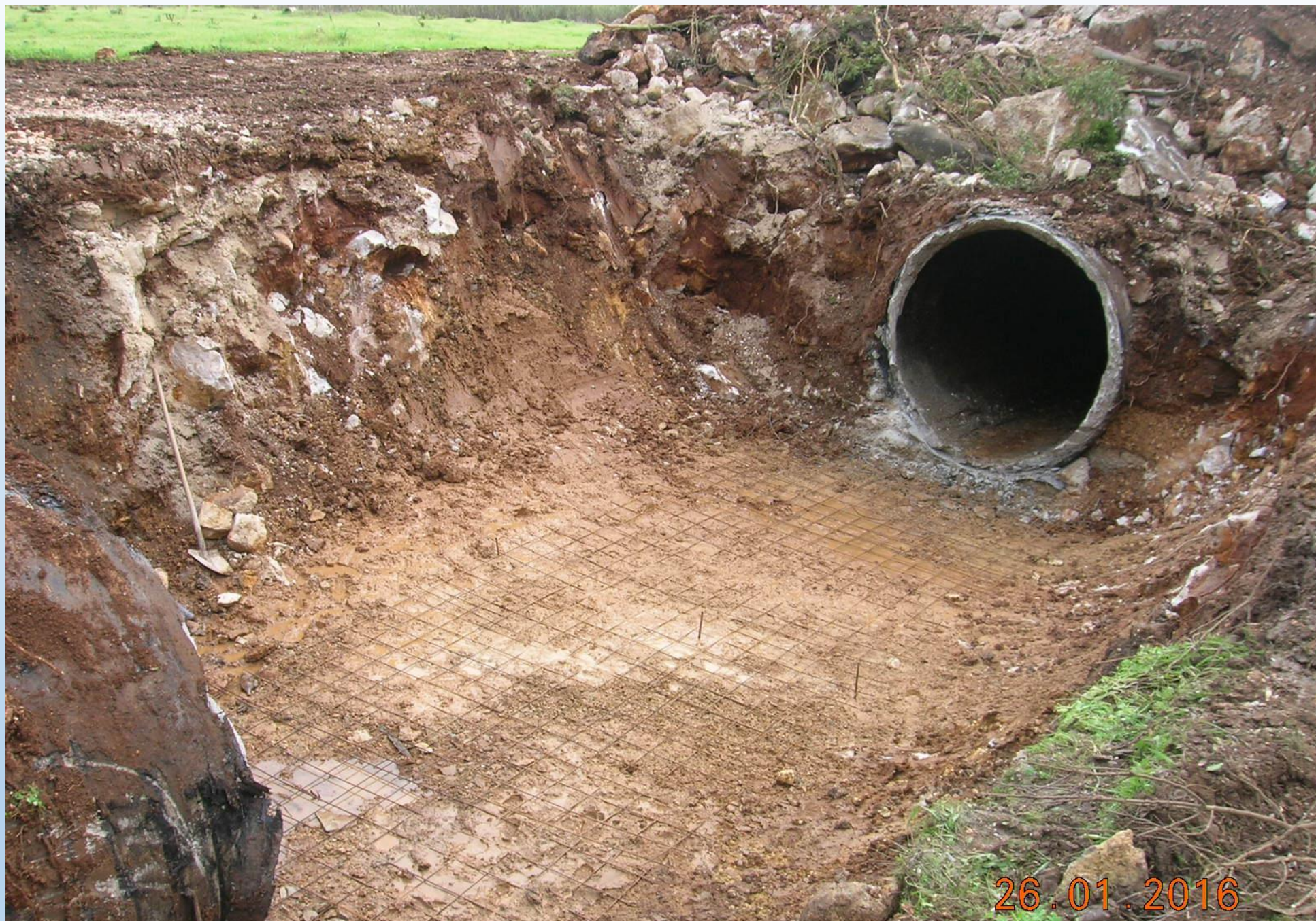
STAZIONE DI SPINTA TIPO: ARMATURA DELLA PLATEA
