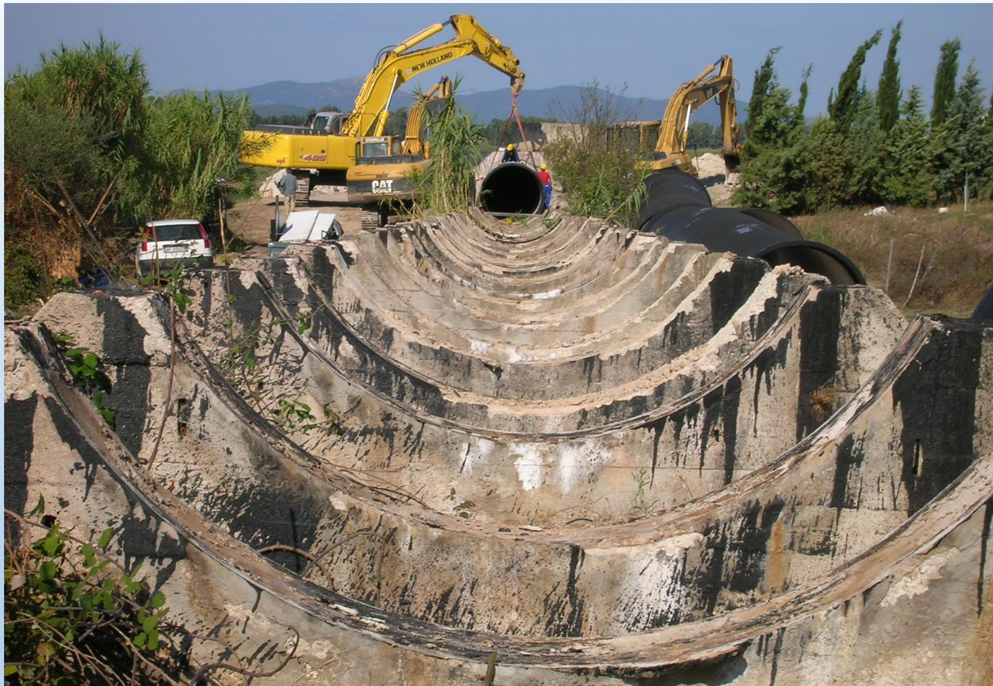
INIZIO OPERAZIONI DI SOSTITUZIONE DELLE TUBAZIONI IN C.A.P. CON TUBAZIONI IN GHISA SFEROIDALE DI PARI DIAMETRO NOMINALE (DN 2.000 MM)
