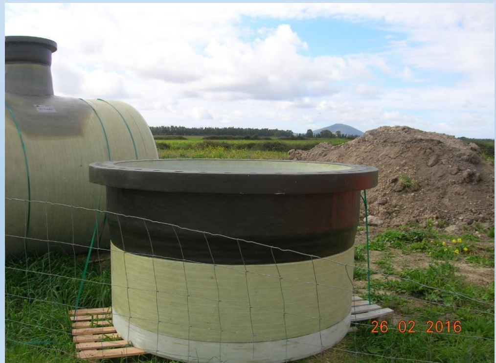
ARRIVO TUBAZIONI E PEZZI SPECIALI IN P.R.F.V. IN CANTIERE
