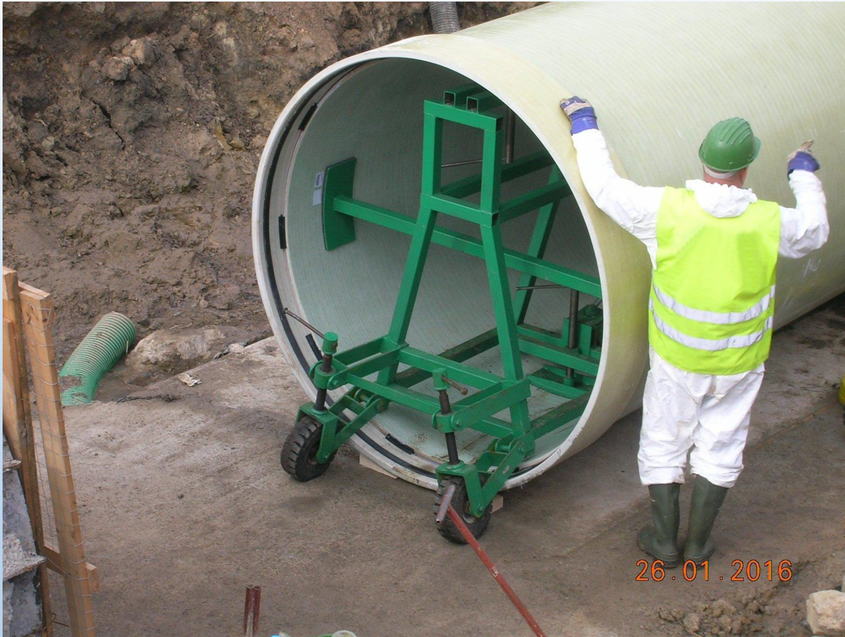
RELINING CON TUBO IN P.R.F.V. DI 1.800 MM
