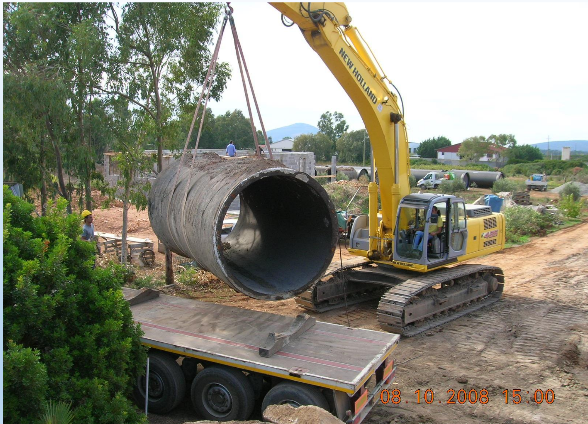
ALLONTANAMENTO DAL CANTIERE DELLE TUBAZIONI IN C.A.P.
