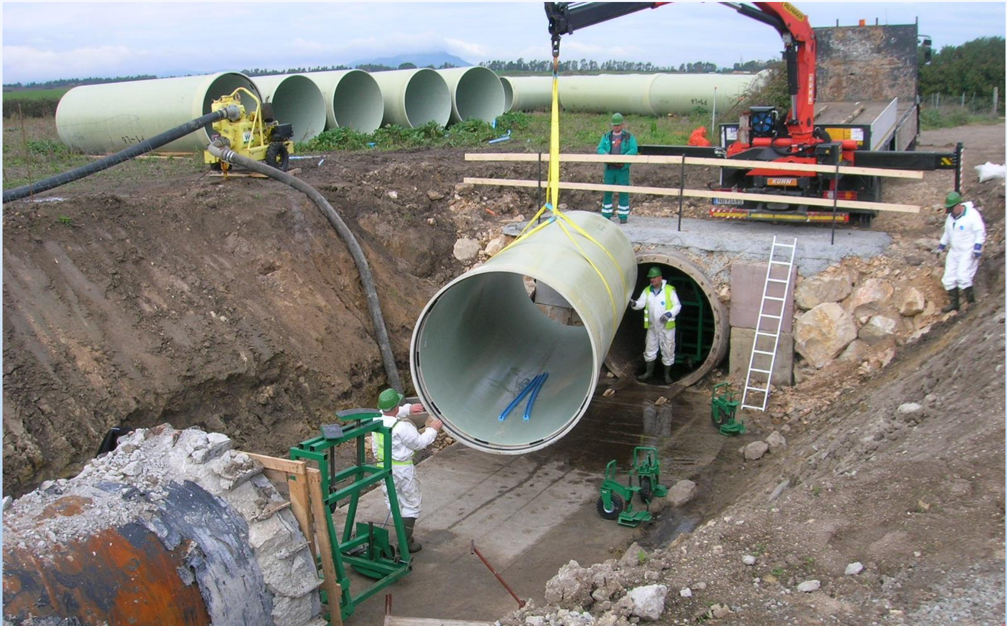
RELINING CON TUBO IN P.R.F.V. DI 1.800 MM
