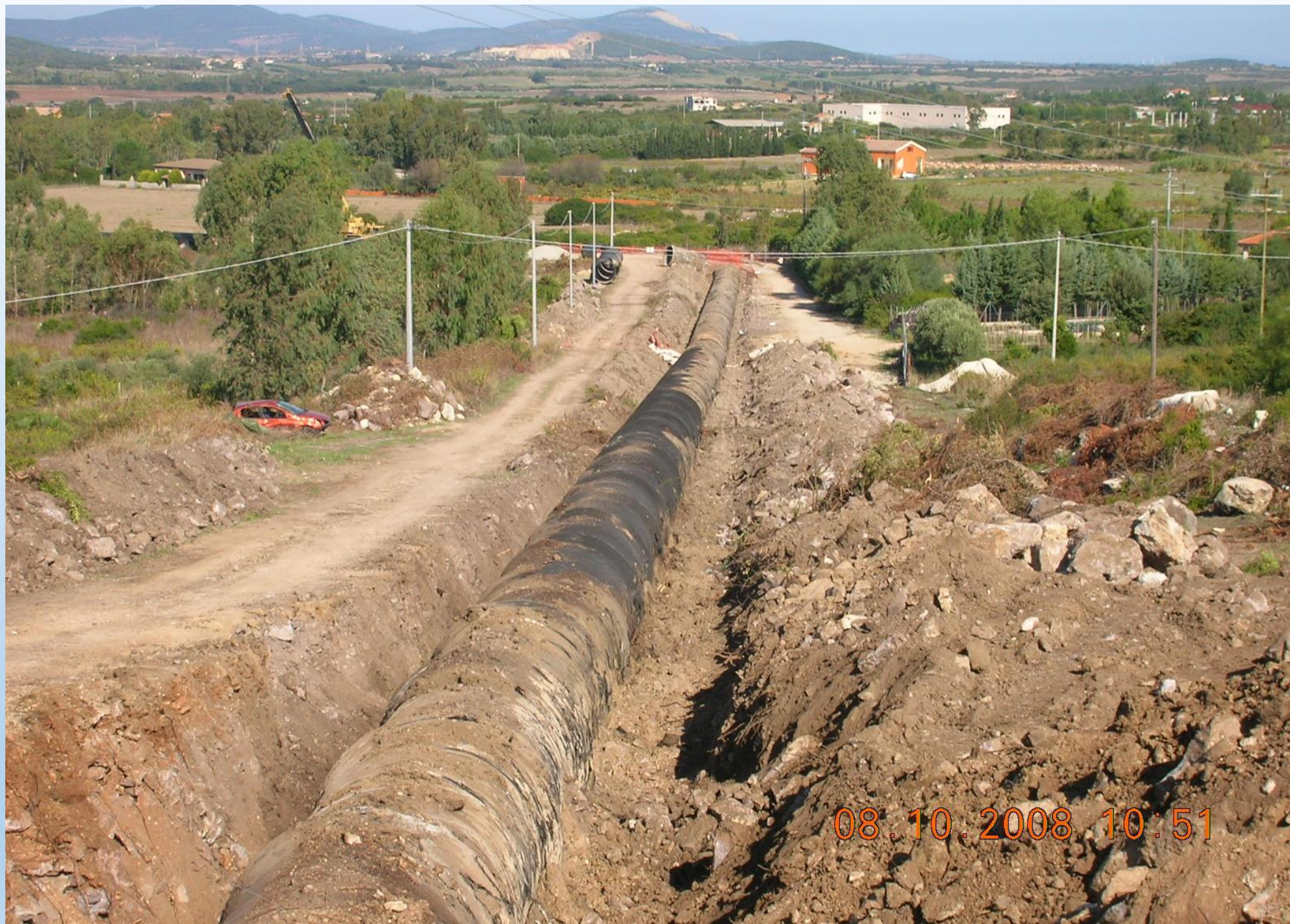
LAVORI DI SCAVO DELLA CONDOTTA IN C.A.P.
