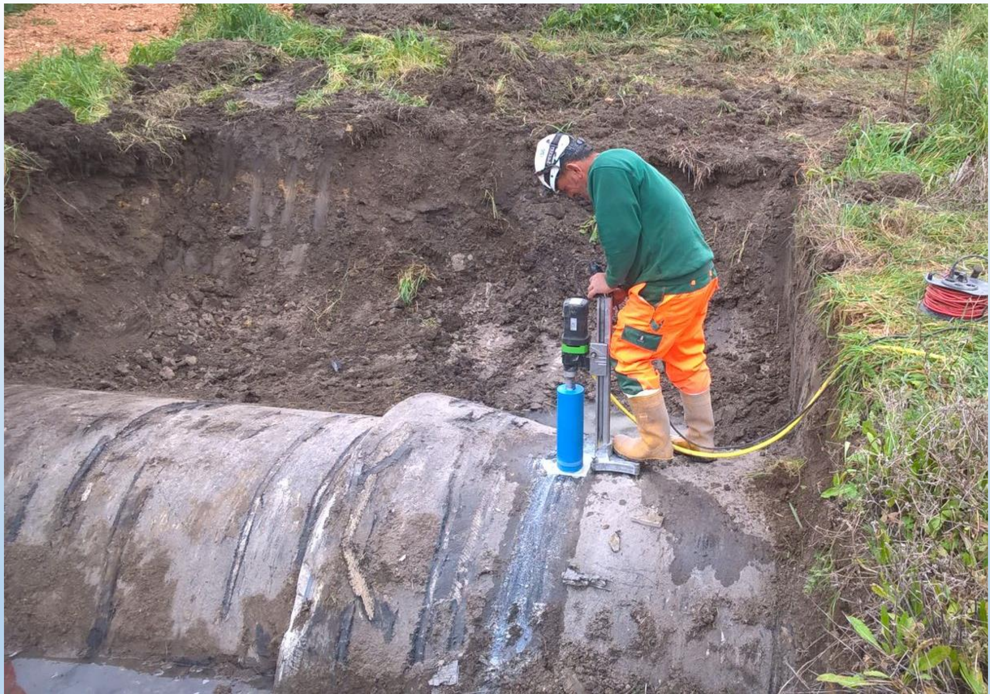
ESECUZIONE DEL FORO DI INIEZIONE E CONTROLLO CON CAROTATRICE
