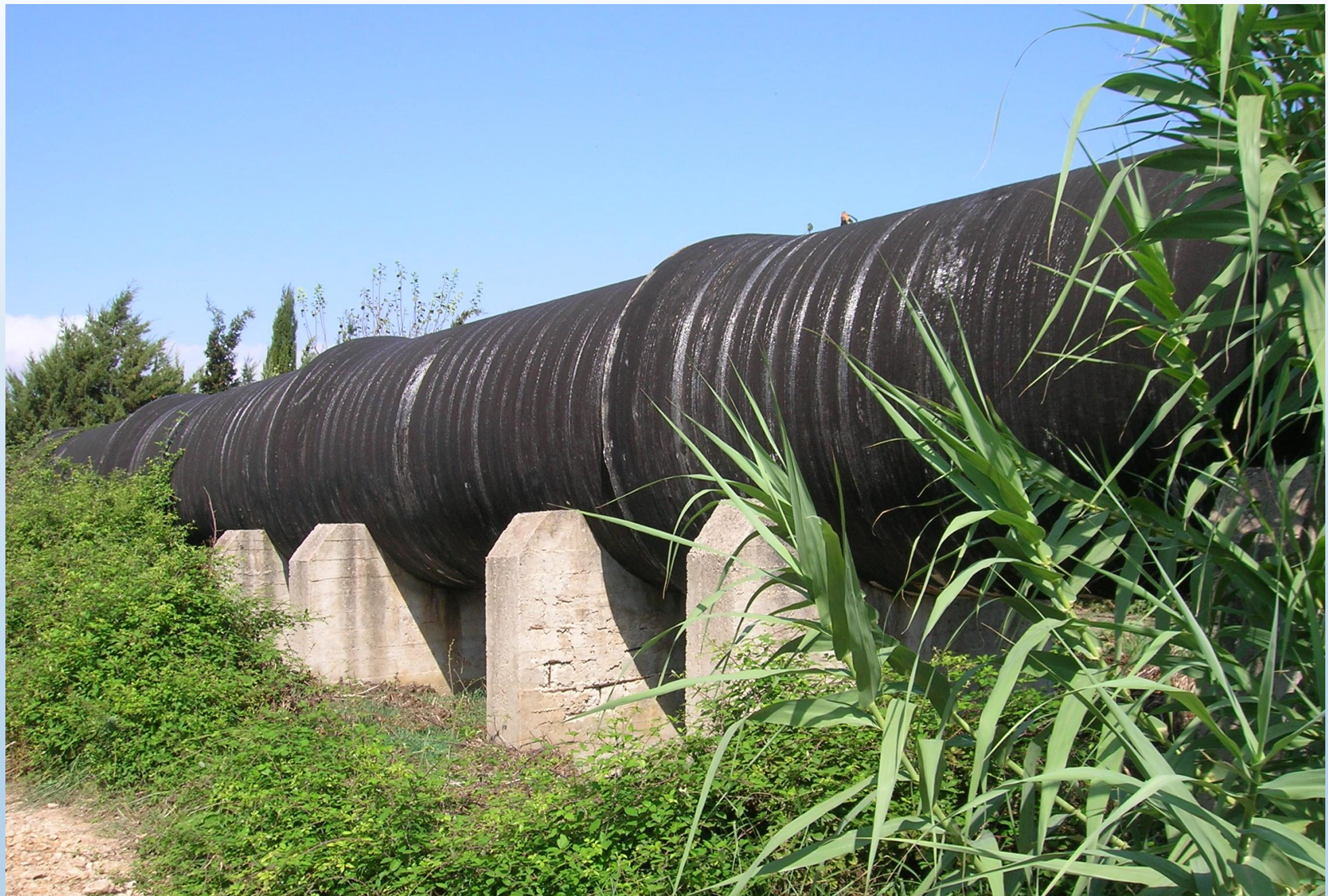
CONDOTTA ADDUTTRICE NORD IN C.A.P. DN 2.000 MM TRATTO SU SELLE DI APPOGGIO
